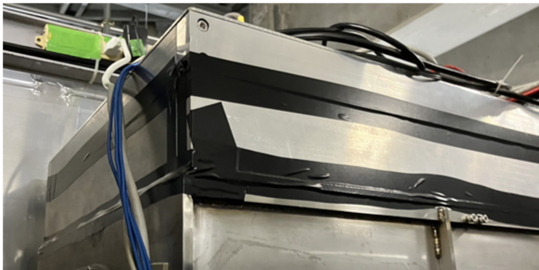
図 6.14 元の構造物と新規構造物との間を遮光した様子
